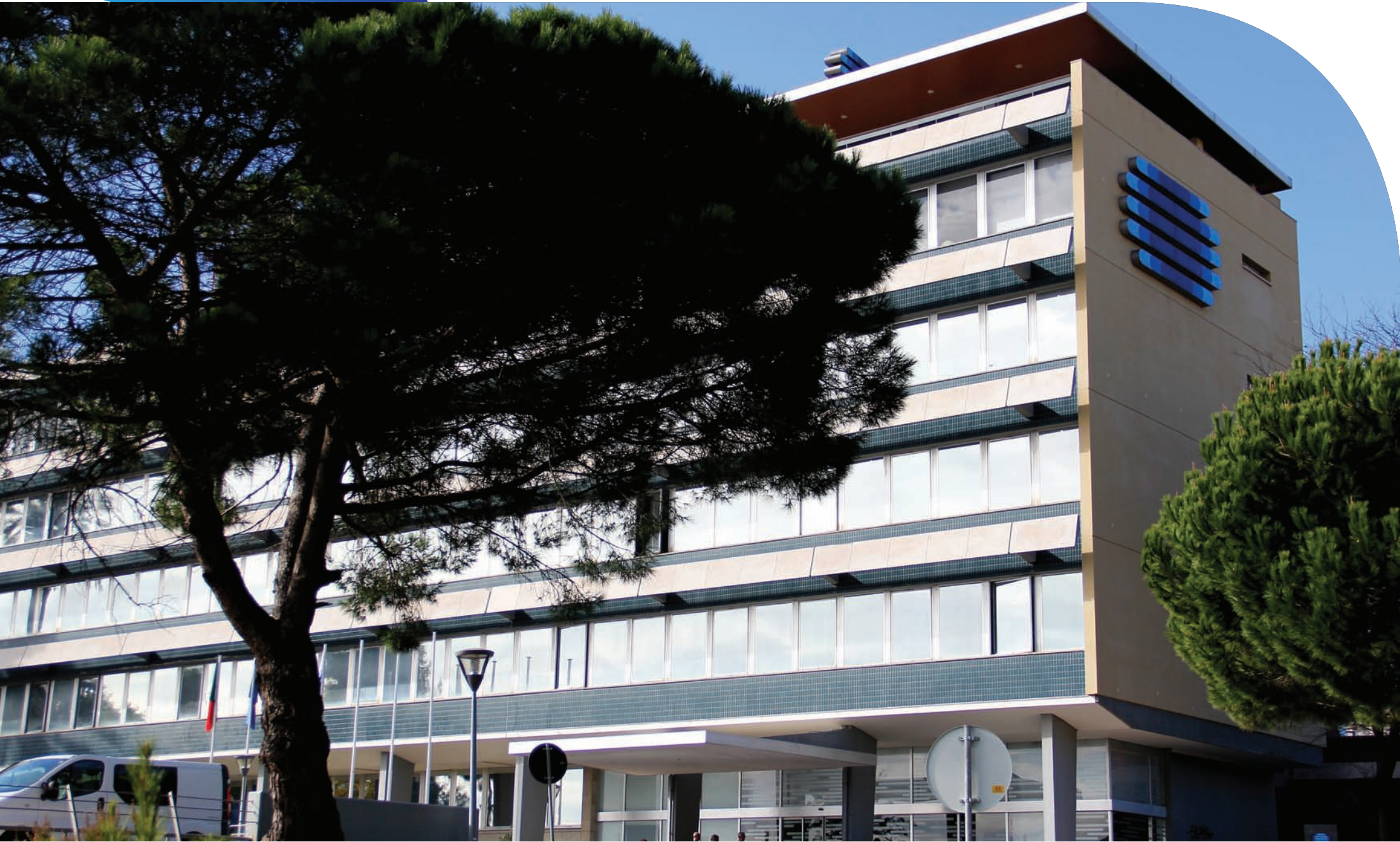
Edifício sede, RTP
