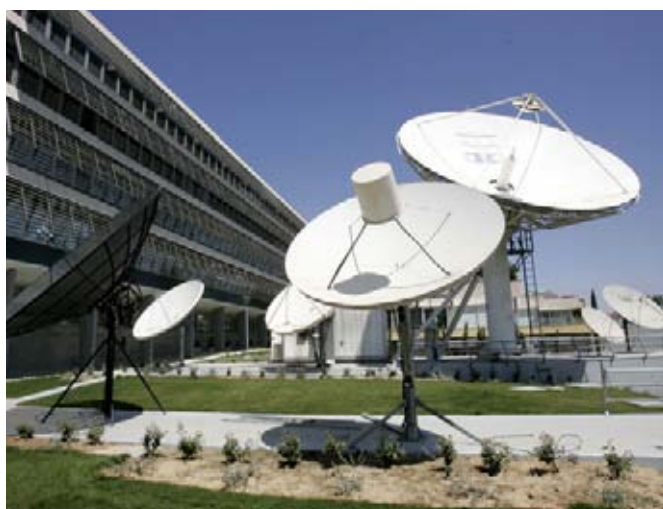
Edifício RTP – Marechal Gomes da Costa – Lisboa
